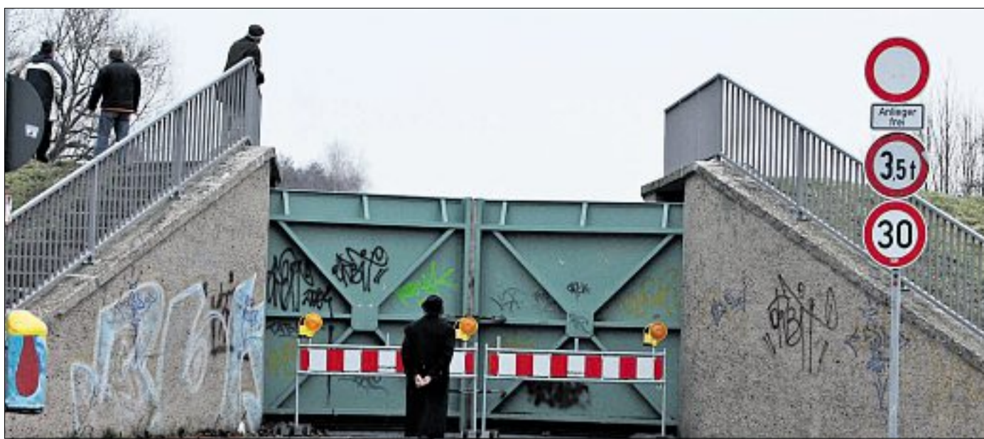
Wenn die Tore geschlossen sind, ist Gefahr in Verzug: Hochwasser erfordert erfahrenes Krisenmanagement am Ricklinger Deich.
